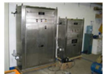
Vista externa - Painel p/ Plataforma de Pampo
