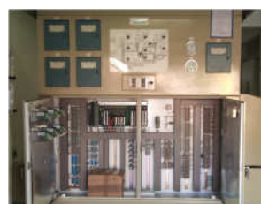
Vista interna frontal
