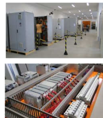
Fábrica e detalhes de montagem
